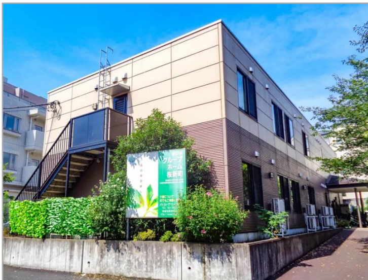
【愛の家グループホーム桜新町の外観】
