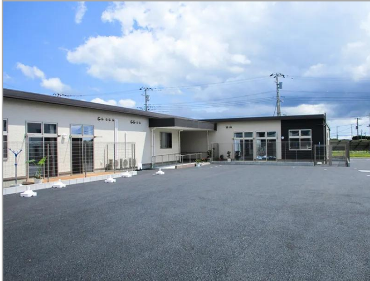
【愛の家グループホーム館山亀ヶ原式番館の外観】
