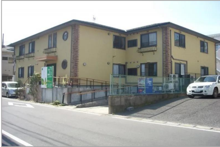
【愛の家グループホーム船橋二子の外観】
