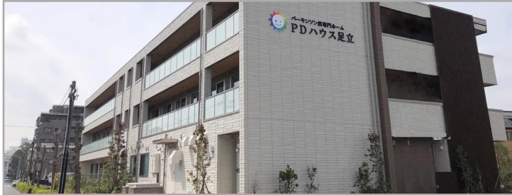
【PDハウス足立の外観】
