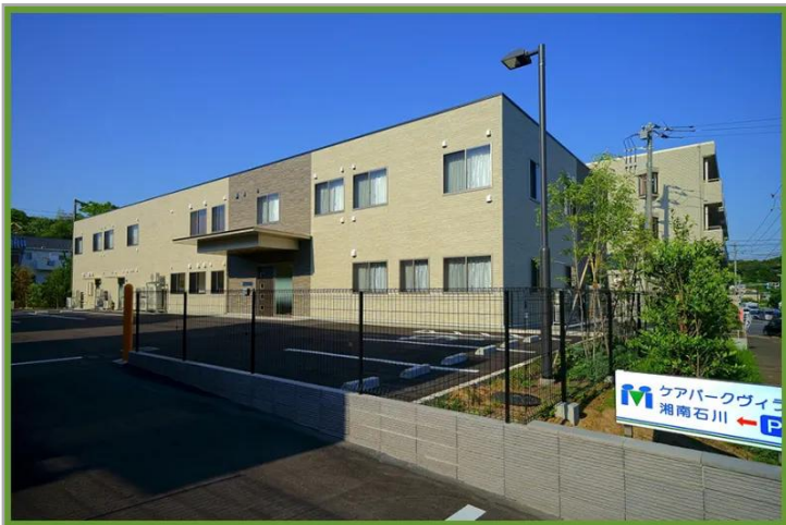
【ケアパークヴィラ湘南石川の施設外観】2019年に建てられたホームです。敷地内に駐車場もございます。
