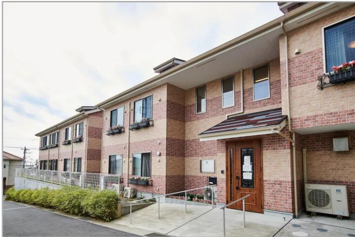
【アスカ大磯の外観】
