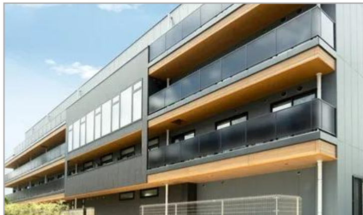
【リアンレーヴ三ツ池公園】施設外観
