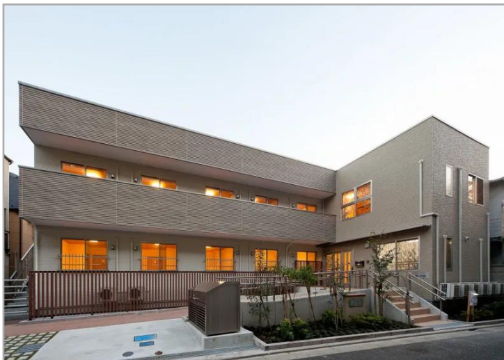
【グループホームきらら世田谷野沢】施設外観
