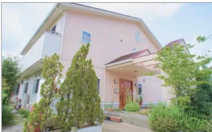
【藤沢ロマン館】外観
