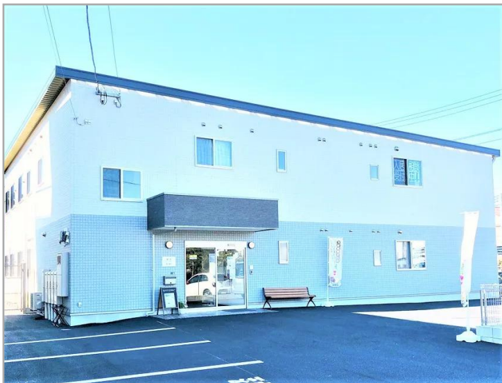
【愛の家グループホーム本庄東台の外観】
