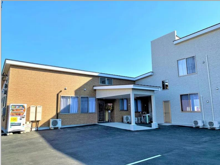
【ヴィベル羽生 外観】2020年12月にオープンした、埼玉県羽生市にある住宅型有料老人ホーム「ヴィベル羽生」です。
