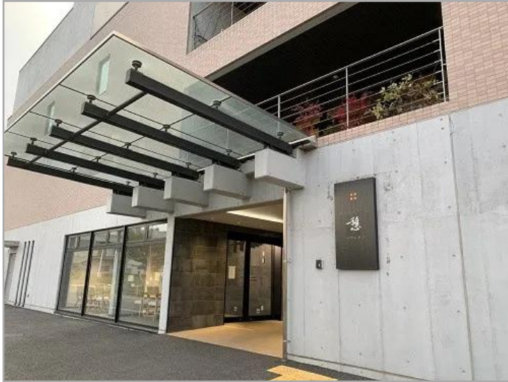
有料老人ホーム 憩：正面玄関
