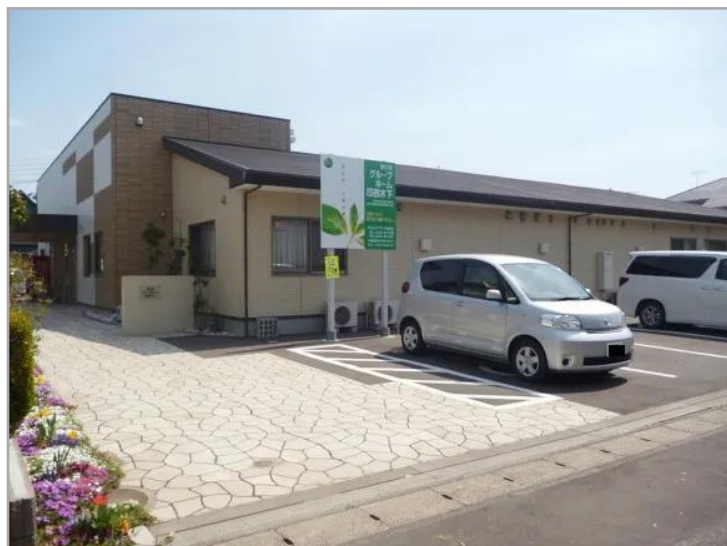
【愛の家グループホーム印西木下の外観】
