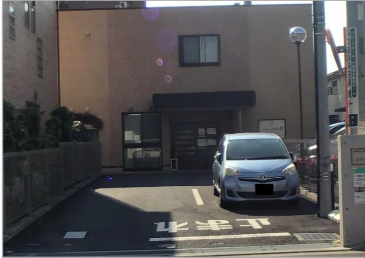
【グループホームふれあい多居夢蕨の外観】
