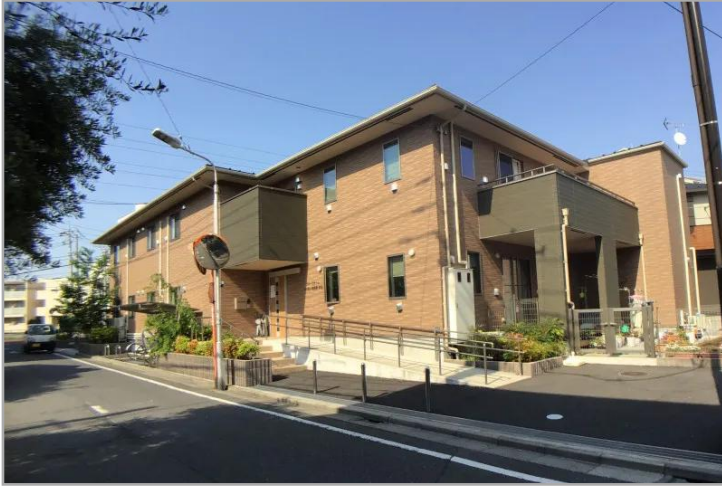
【グループホームふれあい多居夢戸田の外観】
