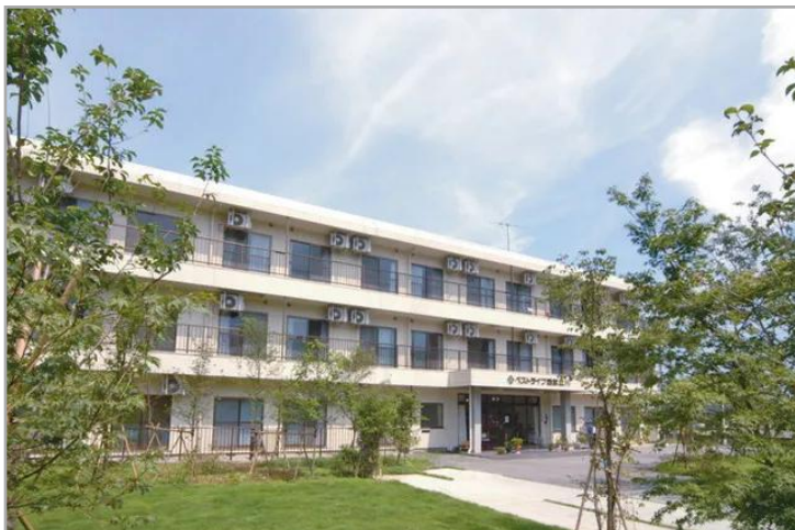
【ベストライフ西武立川】外観
