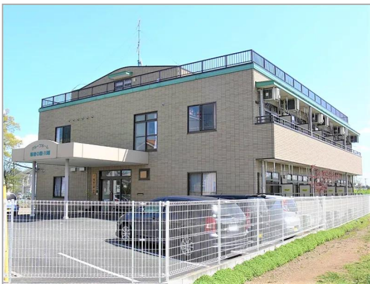
グループホーム福音の園・川越：外観
